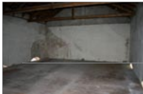
Die obere Etage soll als Lernzentrum für Schüler ausgebaut werden.
